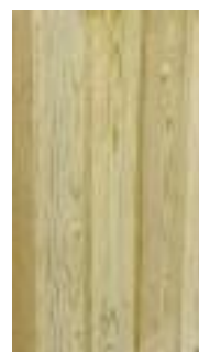
Détail habillage bois
