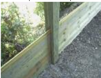
Détail installation mur acoustique
