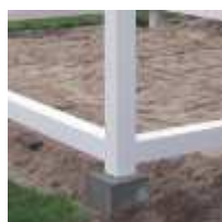
Fondation sur pieux
